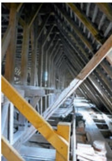
Der Dachstuhl der Klosterkirche mit Blick auf das Gewölbe
